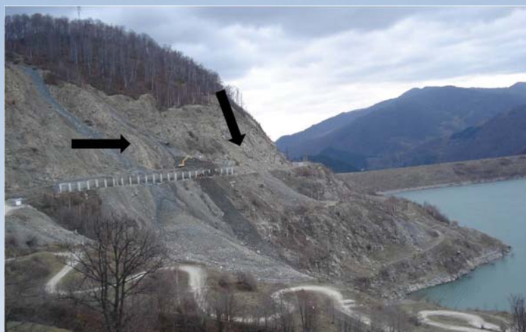
Fig.3 Alunecare de teren afectand DN10 (stanga - fotografie, dreapta - harta de deformare)
